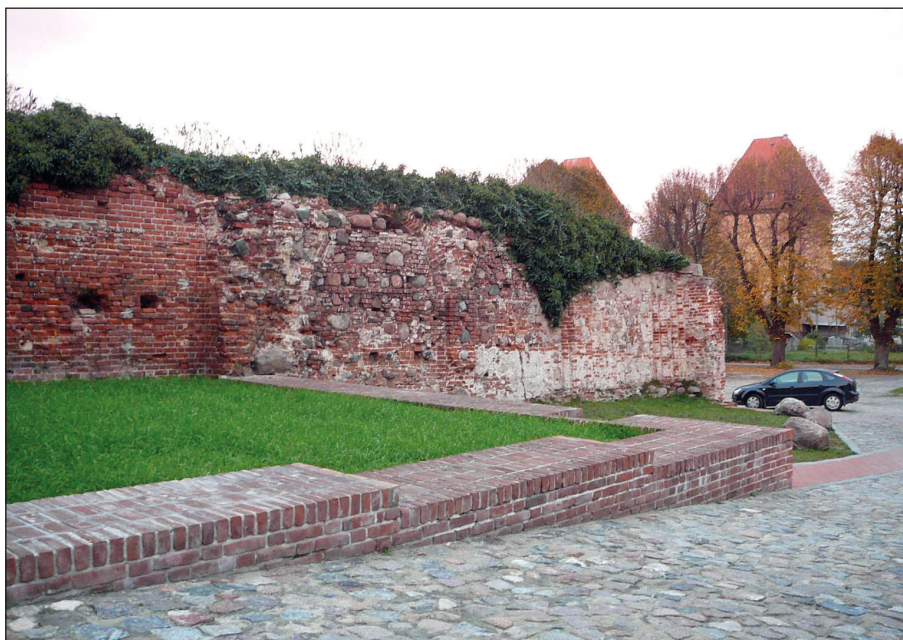
Ryc. 11. Wolin, Stare Miasto, stan. 1, dwór. Północna ściana skrzydła renesansowego z widocznymi oporami sklepień w poziomie parteru. Fot. T. Balcerzak
