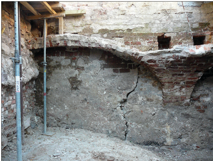
Ryc. 10. Wolin, Stare Miasto, stan. 1, dwór. Północna ściana gotycka zamku z widocznymi późniejszymi sklepieniami, w poziomie piwnic. Fot. T. Balcerzak
